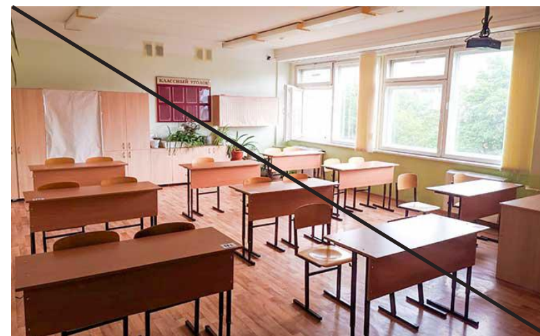
Плохо Линолеум под дерево
